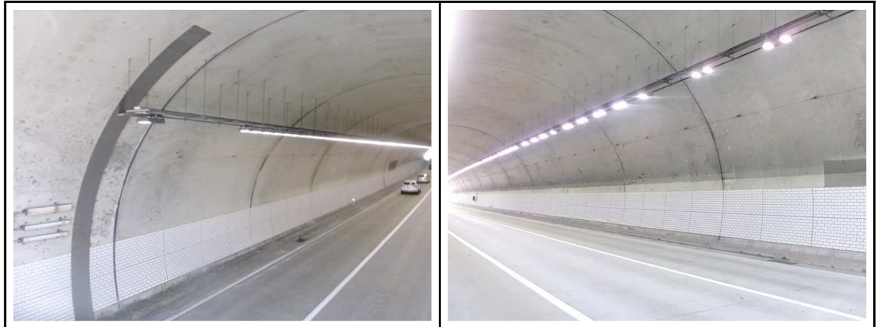
【사진 3.3.3】 측벽부 전경
