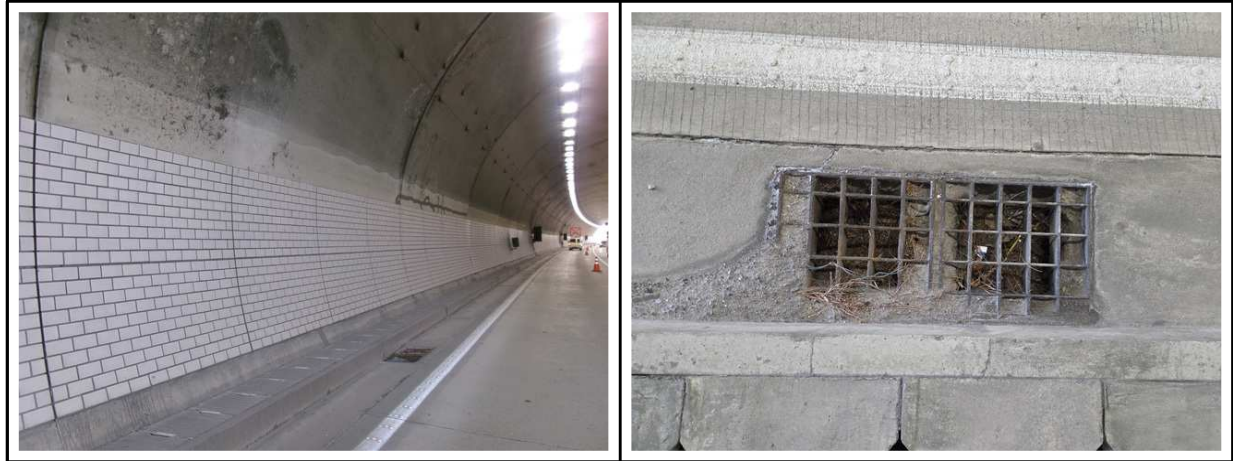
【사진 3.3.11】 배수시설 전경
