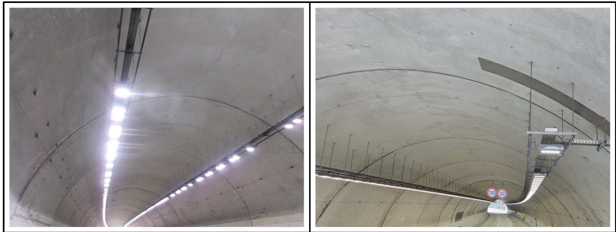
【사진 3.3.1】 천장부 전경
