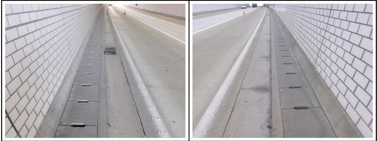
【사진 3.3.9】 공동구 전경
