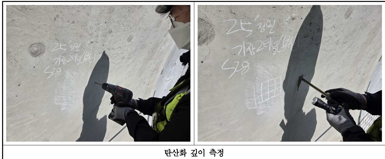
【사진 3.4.2】 탄산화 깊이 시험 현장사진
