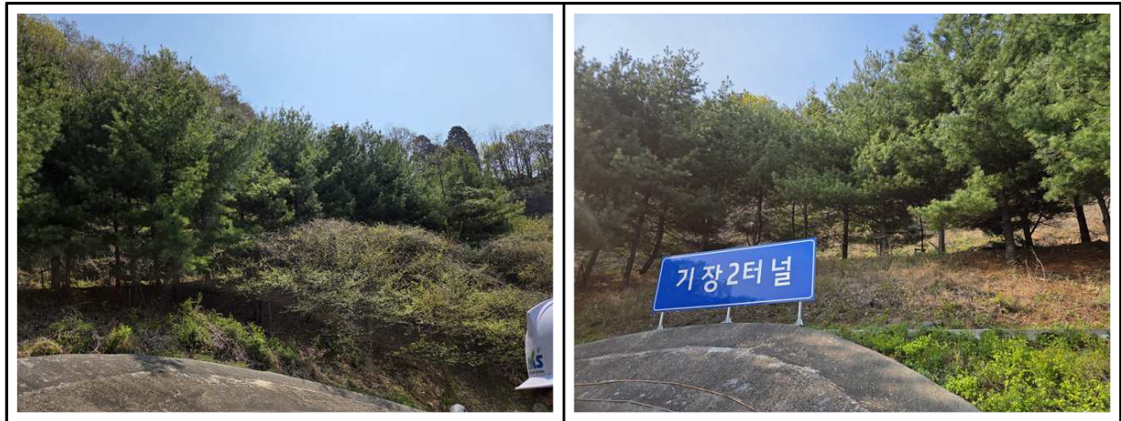
【사진 3.3.7】 사면 전경
