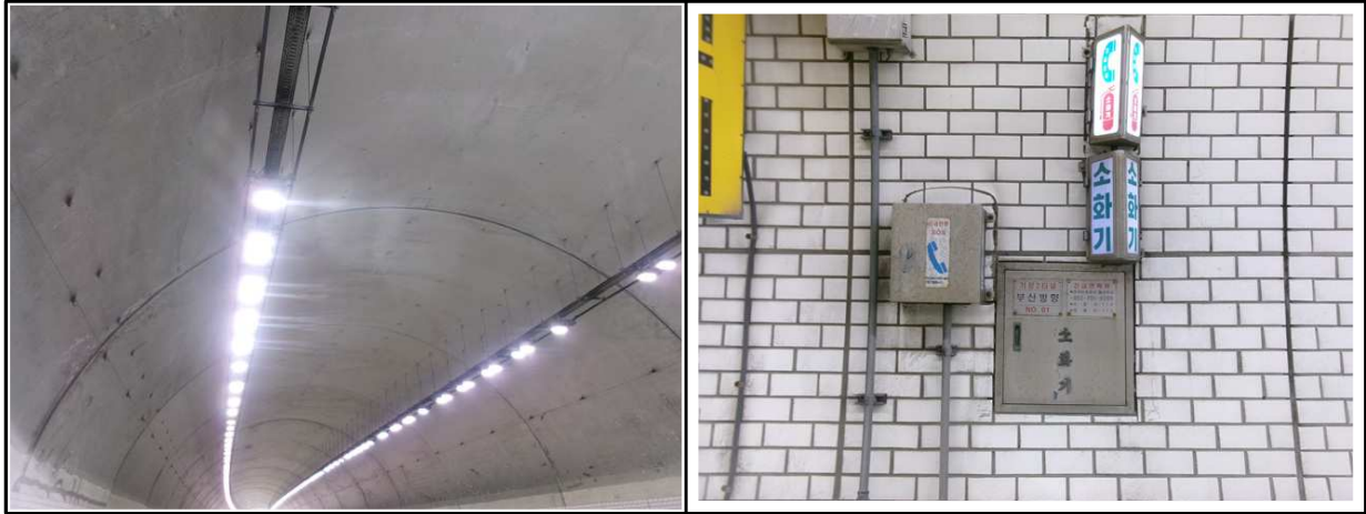
【사진 3.3.15】 기타부속시설 전경
